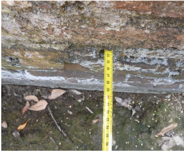
Figura 28 Krisja/çarja në lartësinë veriperëndimore, në pothuajse 40% të trashësisë së murit. Figura 29 Hetimi endoskopik i dëmtimit.
