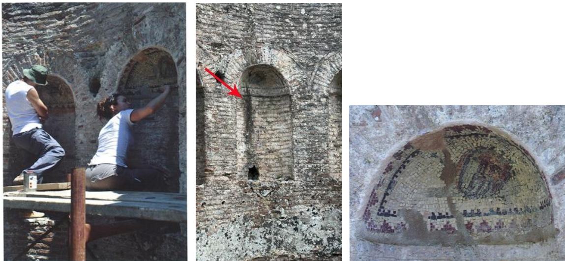
Figura 38, 39, 40. Restaurimi i vitit 2012, detaje nga infiltrimi i ujit, mozaiku i nishes qëndrore
