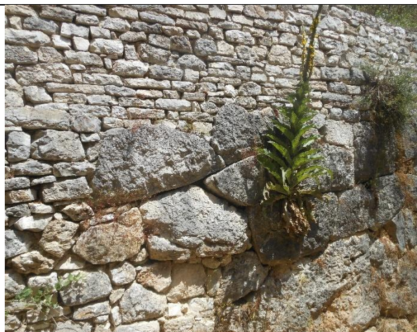
Figura 9. Detaje të teknikave të ndryshme të ndërtimit të përdorura për ndërtimin e murit. Blloqe të mëdha guri mbi të cilat vendosen gurë të vegjël kuadratikë, ndoshta në periudhën mesjetare.
