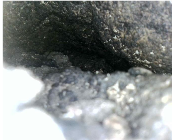
Figura 28 Krisja/çarja në lartësinë veriperëndimore, në pothuajse 40% të trashësisë së murit. Figura 29 Hetimi endoskopik i dëmtimit.
