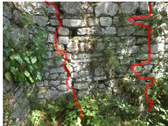
Figura 4. Krisje/çarje vertikale përgjatë gjithë gjatësisë së murit
