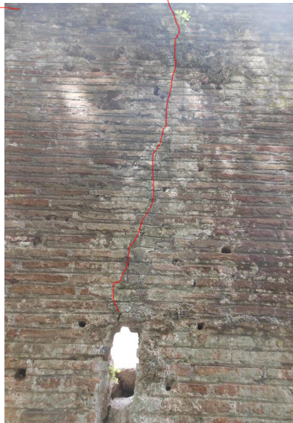
Figura 26 & 27 Lartësia verilindore. Krisje/çarje horizontale në pjesën e sipërme, e dukshme edhe në lartësinë jugperëndimore në nivelin e bazës së nishes. Kjo do të thotë se krisja përkrah të tërë trashësinë e murit. Kësaj krisjeje i shtohen: një krisje e lakuar deri në bazën e strukturës dhe një krisje me prirje vertikale në mes të murit që arrin deri në majën e tij (shih foton ngjitur).
