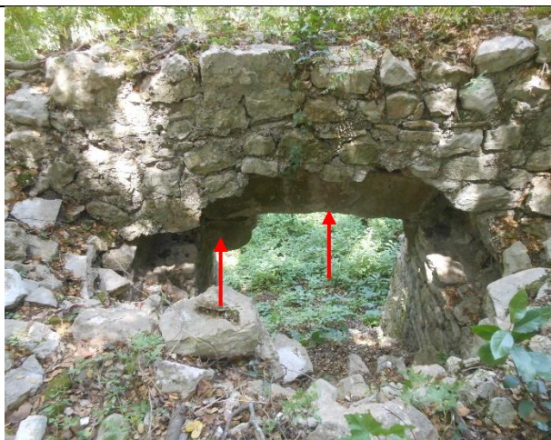
Figura 17. “Portë” ose një hyrje ditësore në murin rrethues 10. Vërehet mungesa e blloqeve të harkut të dikurshëm të hyrjes, mbi portë.
