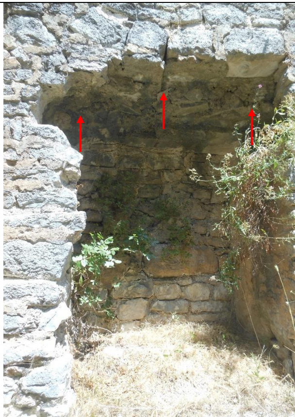
Figura 11. Nishe/ zgavra pa arkitra, në pjesën e murit të qytetit pas ambienteve të “ish kafeterisë”.
