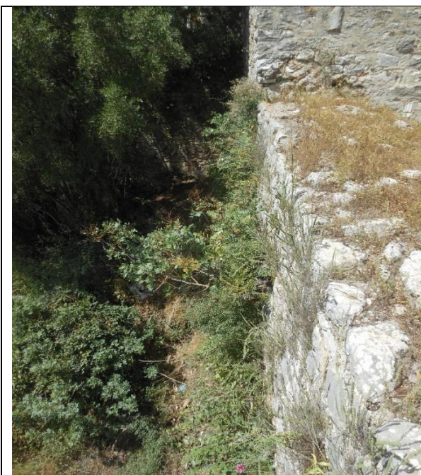
Figura 7. Pjesë e murit ngjitur me fortesën. Përveç mungesës së parrmakëve për sigurinë e vizitorëve, vegjetacion i dendur mund të shihet në paretet dhe faqen e murit.
