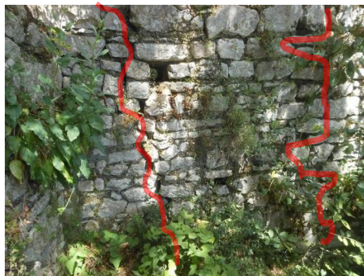
Figura 4. Krisje/çarje vertikale përgjatë gjithë gjatësisë së murit
