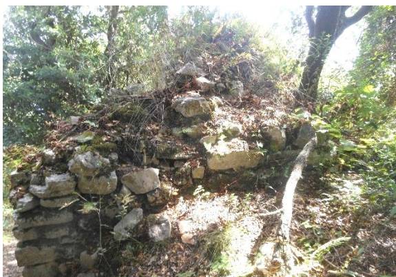
Figura 3. Kreu i mureve, muratura të lirshme dhe të degraduara.
