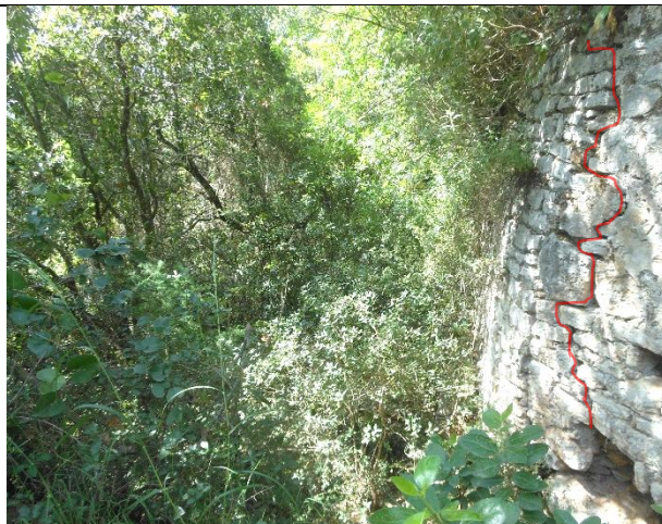
Figura 6. Muri ka një fryrje të dukshme si dhe një krisje/çarje vertikale.
