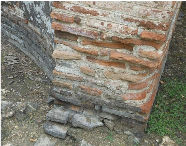
Figura 19 & 20 Erozion i fugave të llaçit dhe tullave në strukturat e gjymnazit
