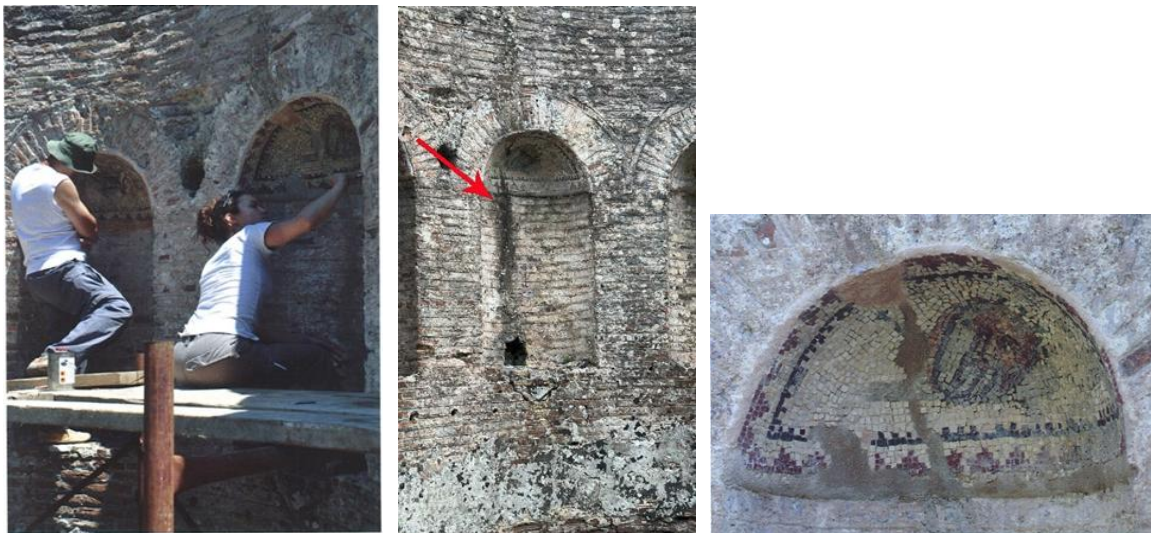
Figura 38, 39, 40. Restaurimi i vitit 2012, detaje nga infiltrimi i ujit, mozaiku i nishes qendrore
