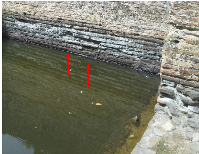
Figura 19 & 20 Erozion i fugave të llaçit dhe tullave në strukturat e gjymnazit
