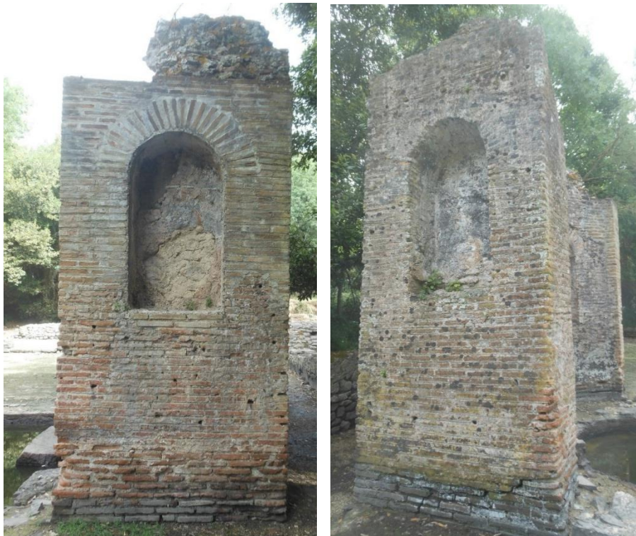
Figura 21 & 22 degradime dhe çarje të strukturës të evidentuara në pjesën e nisheve dhe në bazën e strukturës
