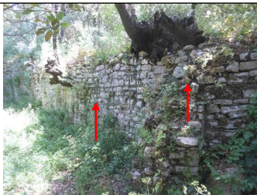
Figura 13. Pemë në majë të murit dhe bimësi në të gjithë faqen ballore, të cilat kanë degraduar murin.
